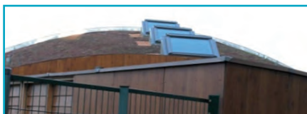
Lanternaux vus de l'extérieur
