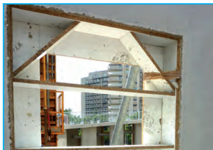
Réservation en bois (© Gestion Conseil Bâtiment)
