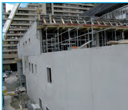
Façade Sud-Est en béton peu vitrée
