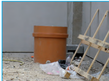
Prise d'air du puits canadien
