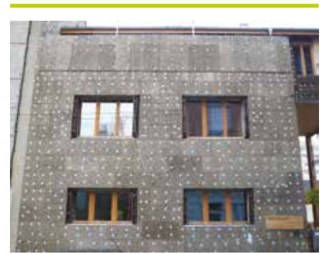
Isolation thermique par l'extérieur avec du liège © Raphaële Héliot
