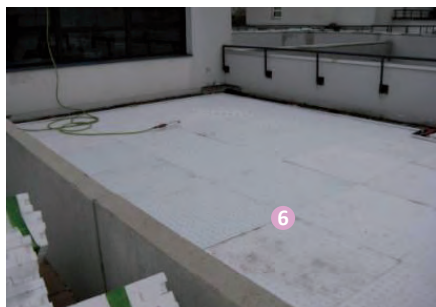
5/ Pose de polystyrène (joue un rôle drainant)
