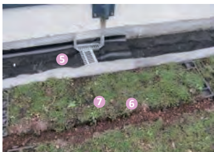
7/ Finition : coupe de la feutrine en excès et pose de gravillons dans les zones stériles autour de chaque émergence
