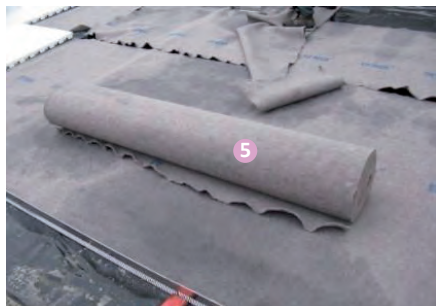
3/ Pose des profils ajourés (délimite les surfaces végétalisées sur l'ensemble de la toiture)
