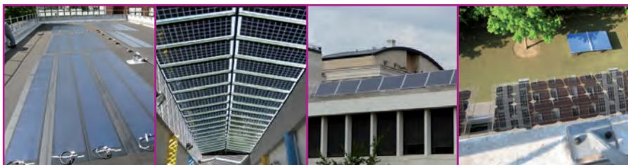
Toitures photovoltaïques d'écoles d'Issy-les-Moulineaux (de gauche à droite) : membrane photovoltaïque et verrière photovoltaïque sur l'école Robert Doisneau, garde-corps photovoltaïques sur l'école Jules Ferry et brise-soleil photovoltaïques sur l'école Saint-Exupéry.
