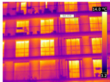
Thermographie d'une des façades de la copropriété
