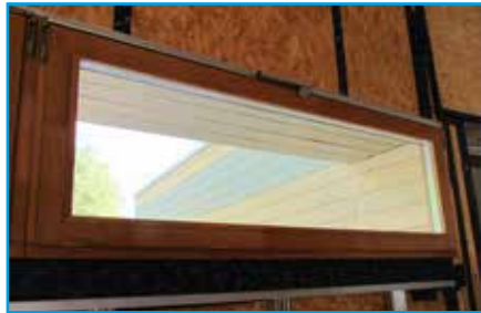
Menuiserie en triple vitrage : une attention particulière a été accordée à l'étanchéité à l'air avec la mise en œuvre de joints pré-comprimés et de membranes spécifiques
