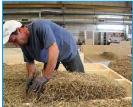
Etape 4 : Mise en œuvre des bottes de paille à la main (©Michel Bulté) Le pourcentage d'humidité de chacune des bottes a été mesuré en amont afin de vérifier que la paille est bien sèche.
