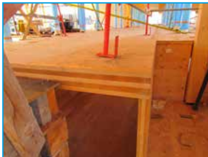
Plancher en panneau bois trois plis contrecollé : il est composé de 3 lames de bois massif collées entre elles, le sens du fil du pli du panneau central étant croisé à 90° par rapport au sens du fil des plis extérieurs, ce qui confère au produit une résistance très élevée.
