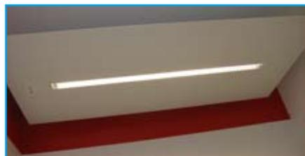
Système « Vélum » assurant le confort phonique, le chauffage et l'éclairage.
