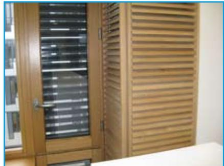
Menuiseries vues de l'intérieur : le coffret bois à droite dissimule le système de ventilation nocturne naturelle par ouvrant de ventilation motorisés, les utilisateurs ont la possibilité d'ouvrir les fenêtres manuellement (grâce à l'ouvrant à gauche).
