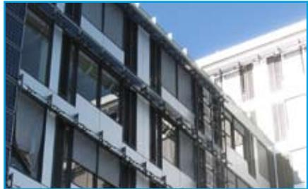
Stores motorisés : les automatismes ferment les stores en fonction de l'ensoleillement, mais les occupants peuvent les actionner manuellement via l'interface « Modulo »
