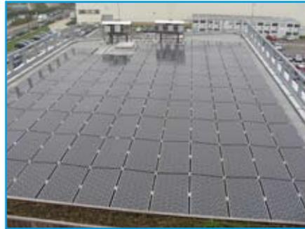
Panneaux photovoltaïques monocrystallins en toiture
