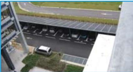
Panneaux photovoltaïques monocrystallins sur les abris voiture
