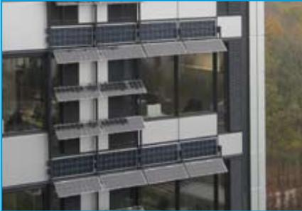
Brises-soleils photovoltaïques et panneaux photovoltaïques polycristallins en bardage
