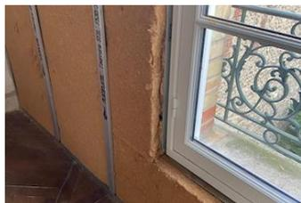
Avec des murs en briques pleines, il était indispensable de mettre en œuvre uniquement des matériaux très ouverts à la vapeur d'eau (fibreux) et capillaires tel que la fibre de bois. L'isolant a été associé à un freine-vapeur hygrovariable.
