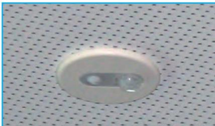
Détecteur de présence et système permettant la gradation de l'éclairage artificiel
