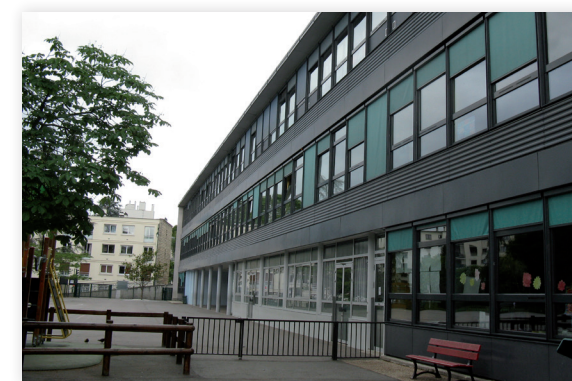
Réalisation d'un bilan énergétique simplifié dans le cadre de l'élaboration de la stratégie énergie sur le patrimoine bâti de Ville-d'Avray
