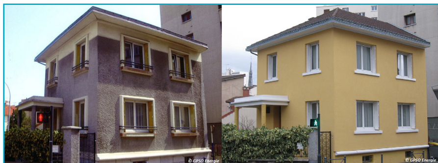
Maison avant travaux
