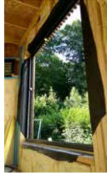
Des volets roulants isolés sont intégrés à la menuiserie des fenêtres équipées, de façon à limiter les ponts thermiques.
