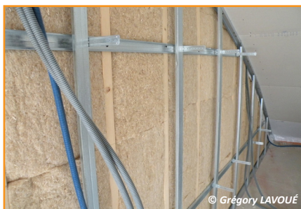
Mise en oeuvre de l'isolant
