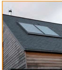
Le capteur thermique permet de chauffer l'eau ou de couvrir une partie des besoins de chauffage.
